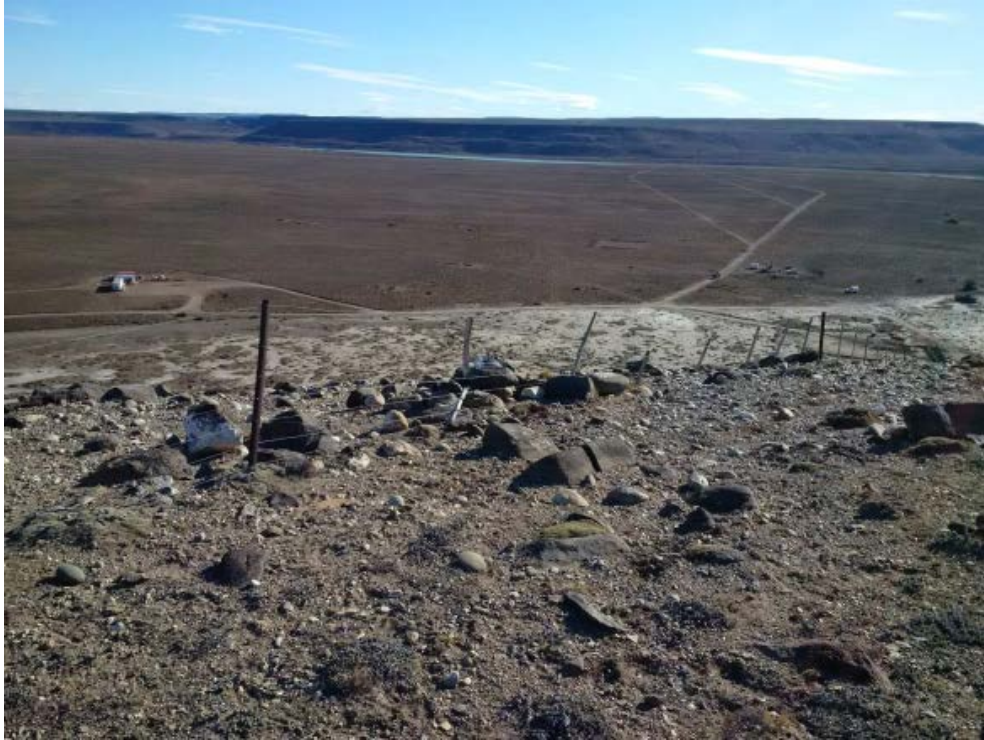
Figura 23: Área de la zona de implantación de las obras permanentes- Presa JC
