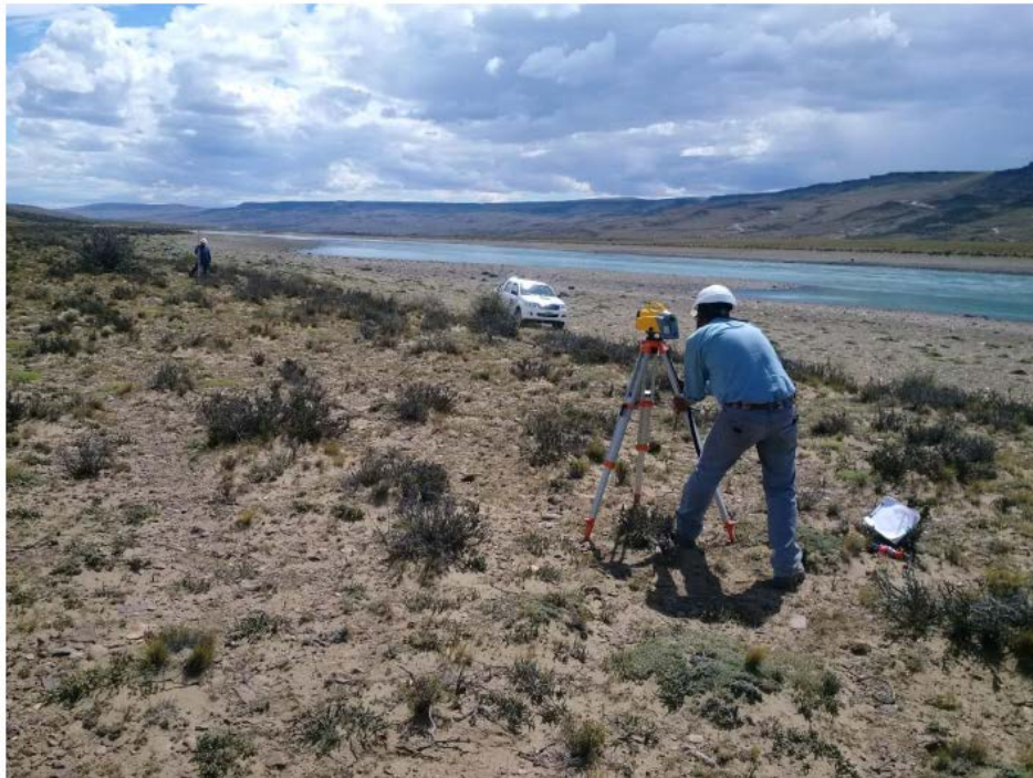
Figura 33: Ejecución de la nivelación geométrica Margen derecha del río santa Cruz
