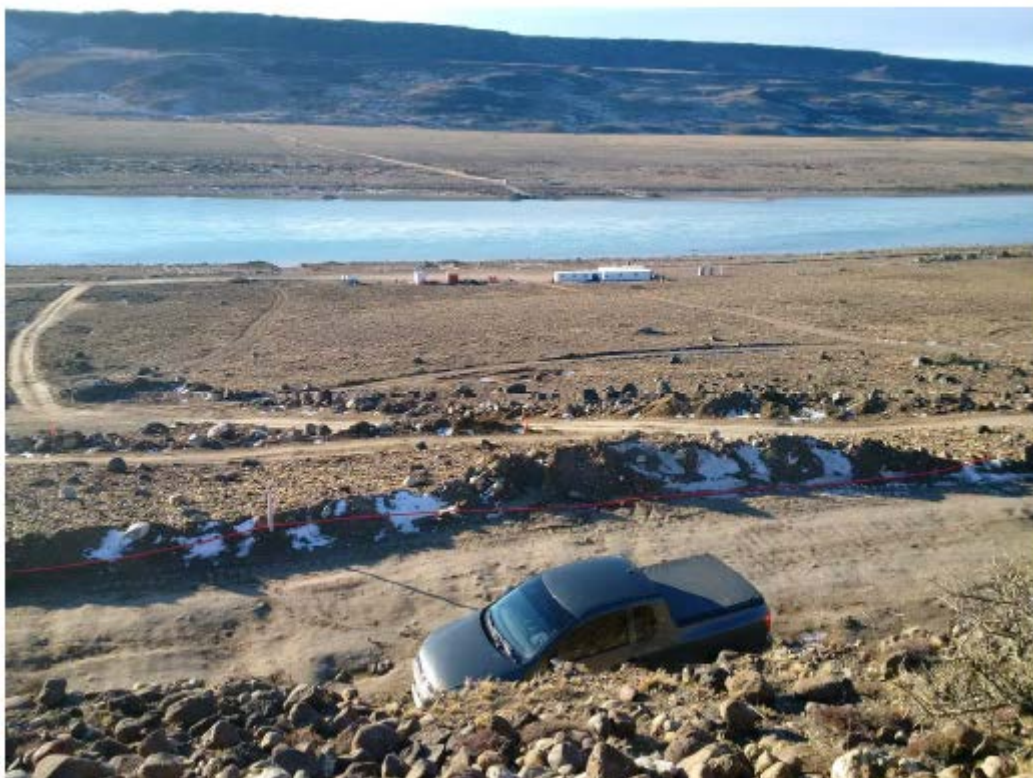
Figura 8: Área de las obras permanentes de la presa NK
